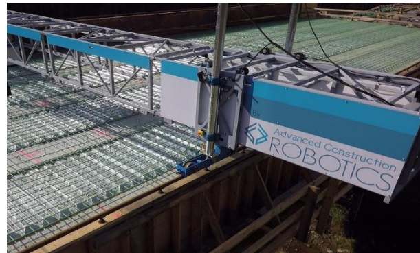
Fig. 21 Robotic cement pouring method.
